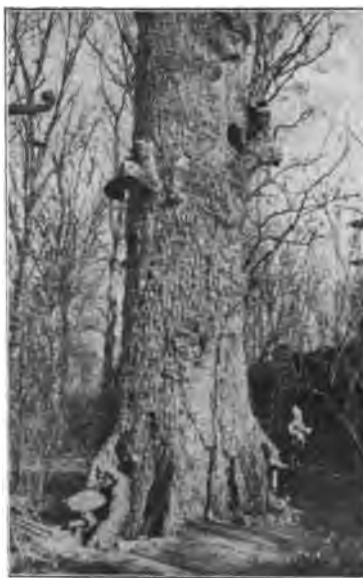
Abb. 115. Schornstein aus Eisenbeton in Gestalt eines Baumstammes in La Malmaison bei Paris.
